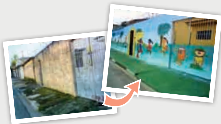
Instalações da creche João de Longe foram recuperadas e a entidade pode continuar em funcionamento
